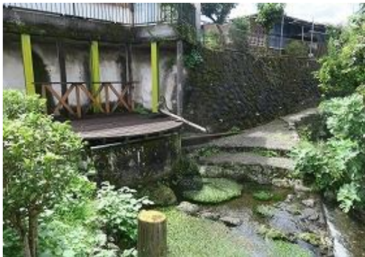
整備前の雷井戸の全景
