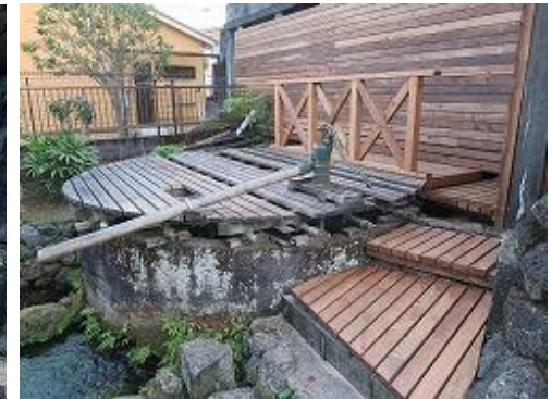
木製階段を設置
