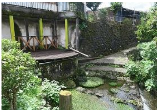
整備前の雷井戸の全景
