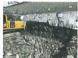
図 降雨時の対策(養生の状況)
