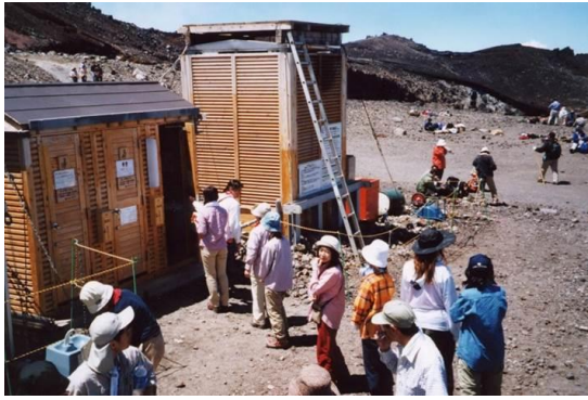
富士山頂に設置したバイオトイレ
