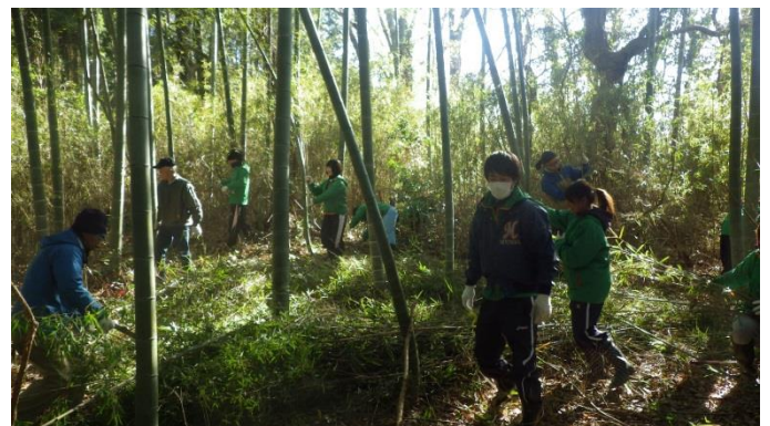
竹林伐採作業(平成27年1月)
