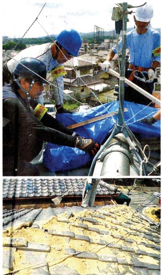
●屋根にブルーシートを張る石岡博美さん(左端) ①瓦がずれ、下地の土が見えている屋根=いずれも大阪府高槻市
