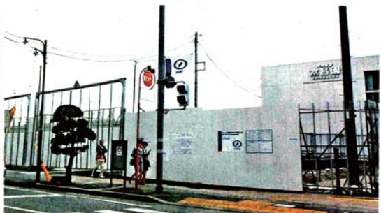
東急がホテル建設を進めている西街区。ホテル開業は当初計画から2カ月遅れ2020年6月にずれ込むことになった=三島市一番町で
