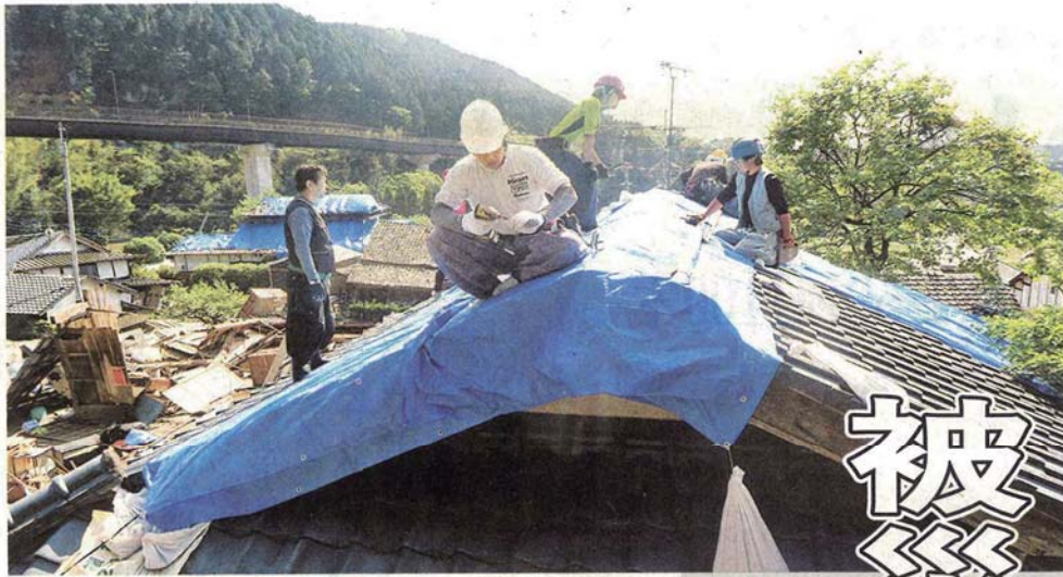
被災した家屋の屋根を補修する職人＝熊本 県大津町で(グラウンドワーク三島提供)
