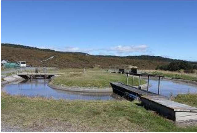
トンガリロ国立公園のビジターセンターより車で 5 分移動したところに下水処理場を設けている 冬のシーズンは観光客増加に伴い量が増すとのこと
