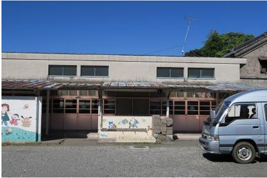
写真③ 保健室 A～C
