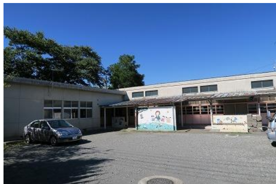
写真② 敷地内全景
