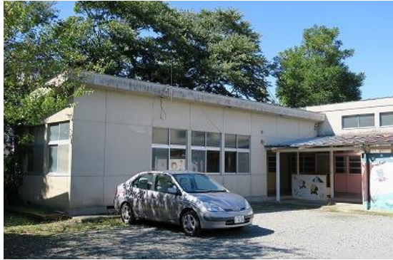
写真④ 職員室・保健室
