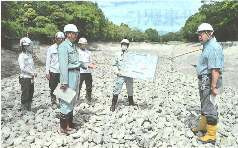
川底を歩き、工事の状況を確認する渡辺専務理事(右)ら三島市と沼津市の境に位置する松毛川
