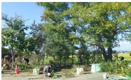
整備中の現場
