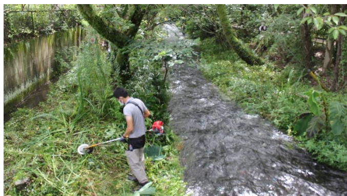
作業場所：水の苑緑地・カワセミ橋付近
