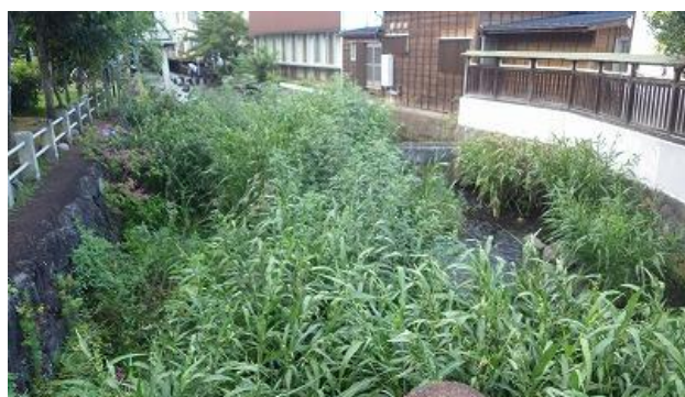
作業場所：源兵衛川中流部・三石神社付近
