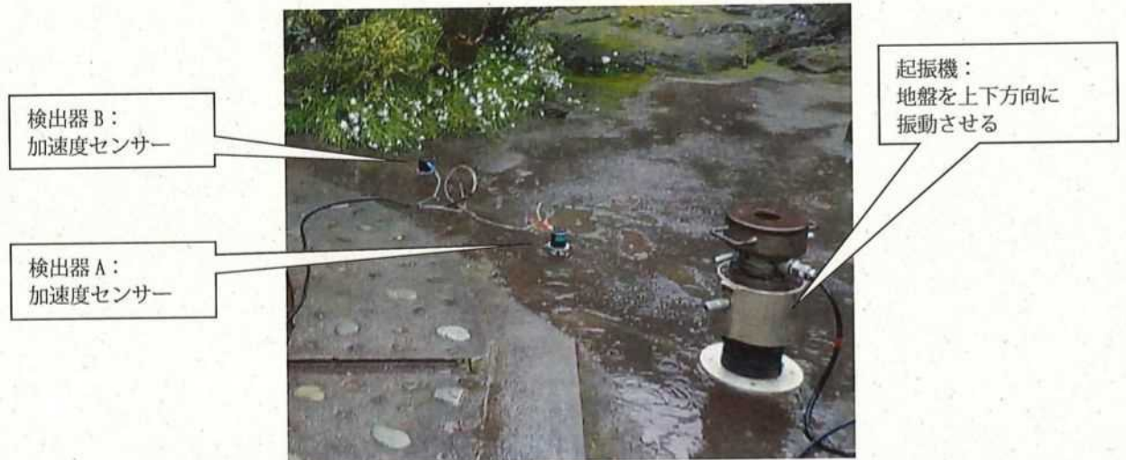
図 3.4.6 表面波探査設置状
