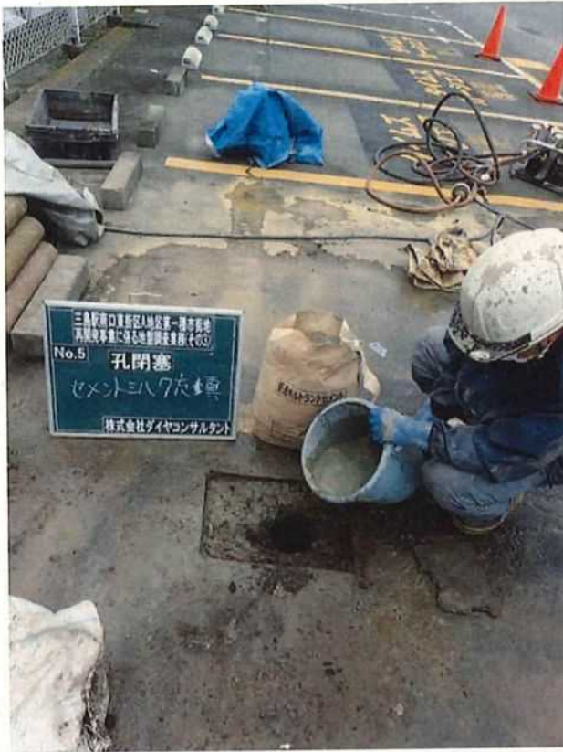
孔内閉塞 (セメントミルク充填)
