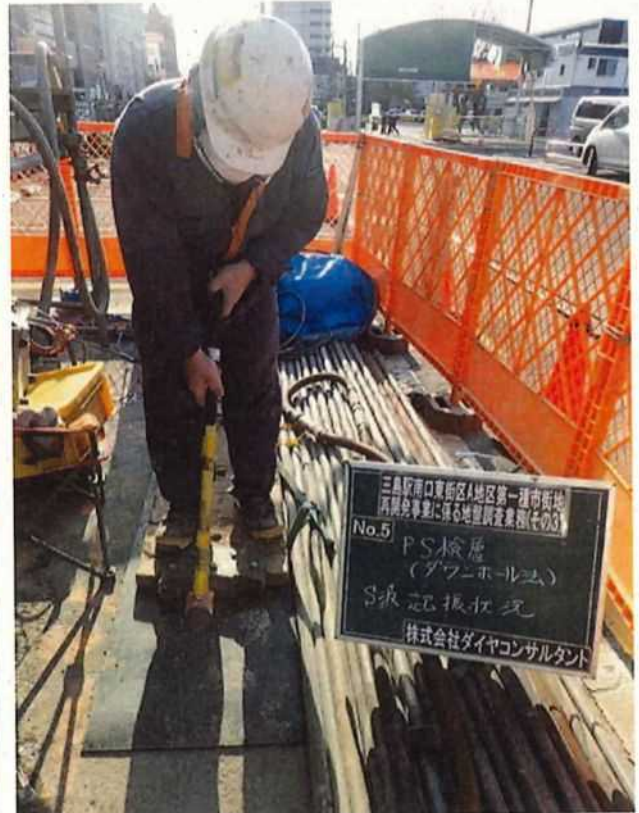
ダウンホールPS検層 S波起振状況
