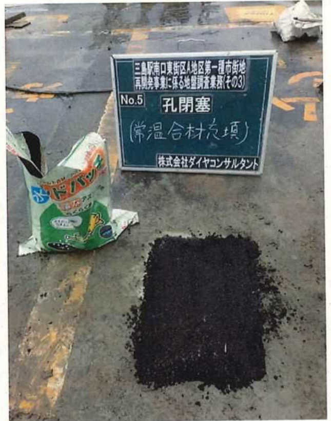
孔内閉塞 (常温)合材充填
