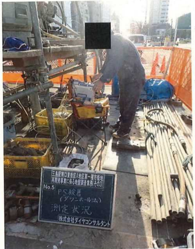
ダウンホールPS検層 測定状況
