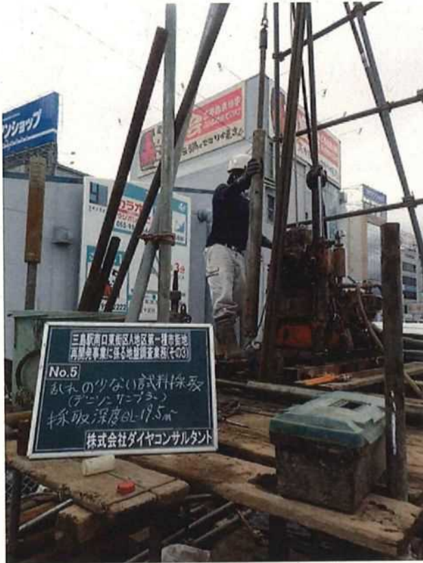
乱れの少ない試料採取 デニソン式サンプリング GL-19.50m～
