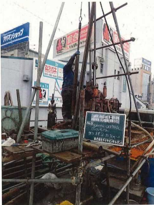
乱れの少ない試料採取 デニソン式サンプリング GL-28.50m～
