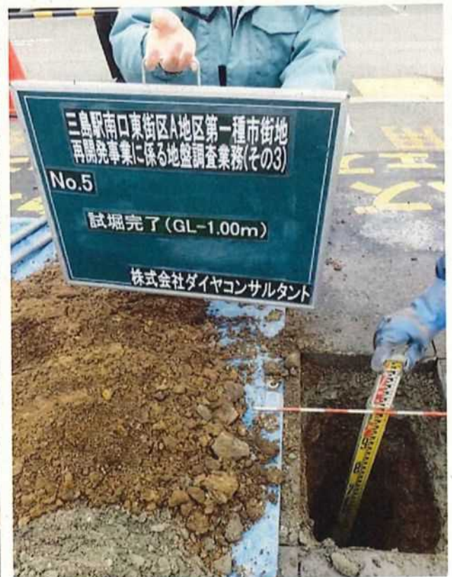
試掘完了 GL-1.00m
