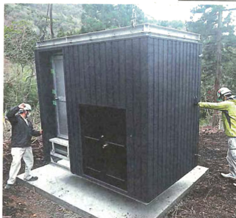
実証実験に向けて設置されたバイオ トイレ＝広島県北広島町
